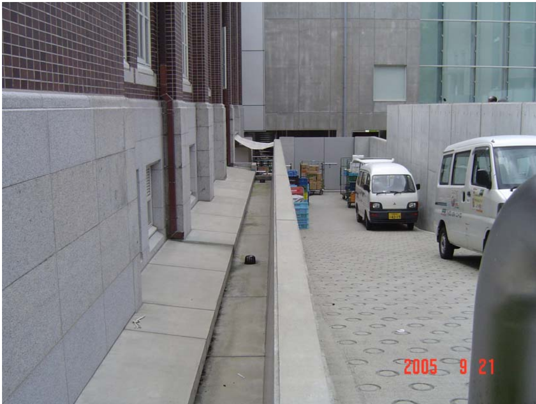
تصویر ۵-۱-الف- فراهم نمودن امکان جابجایی جانبی و قائم در کناره‌های ساختمان جداسازی شده
